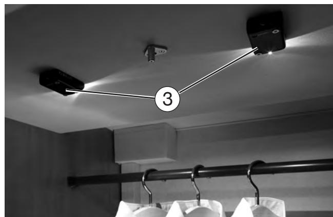
Klesskapsbelysningen ③ slås på med en integrert kontaktbryter når dørene til klesskapet åpnes (kan ikke slås på og av på betjeningspanelet). LED-lampen er batteridrevet. Trekk av folien som beskytter batterikontaktene før du tar i bruk batteriet for første gang.
